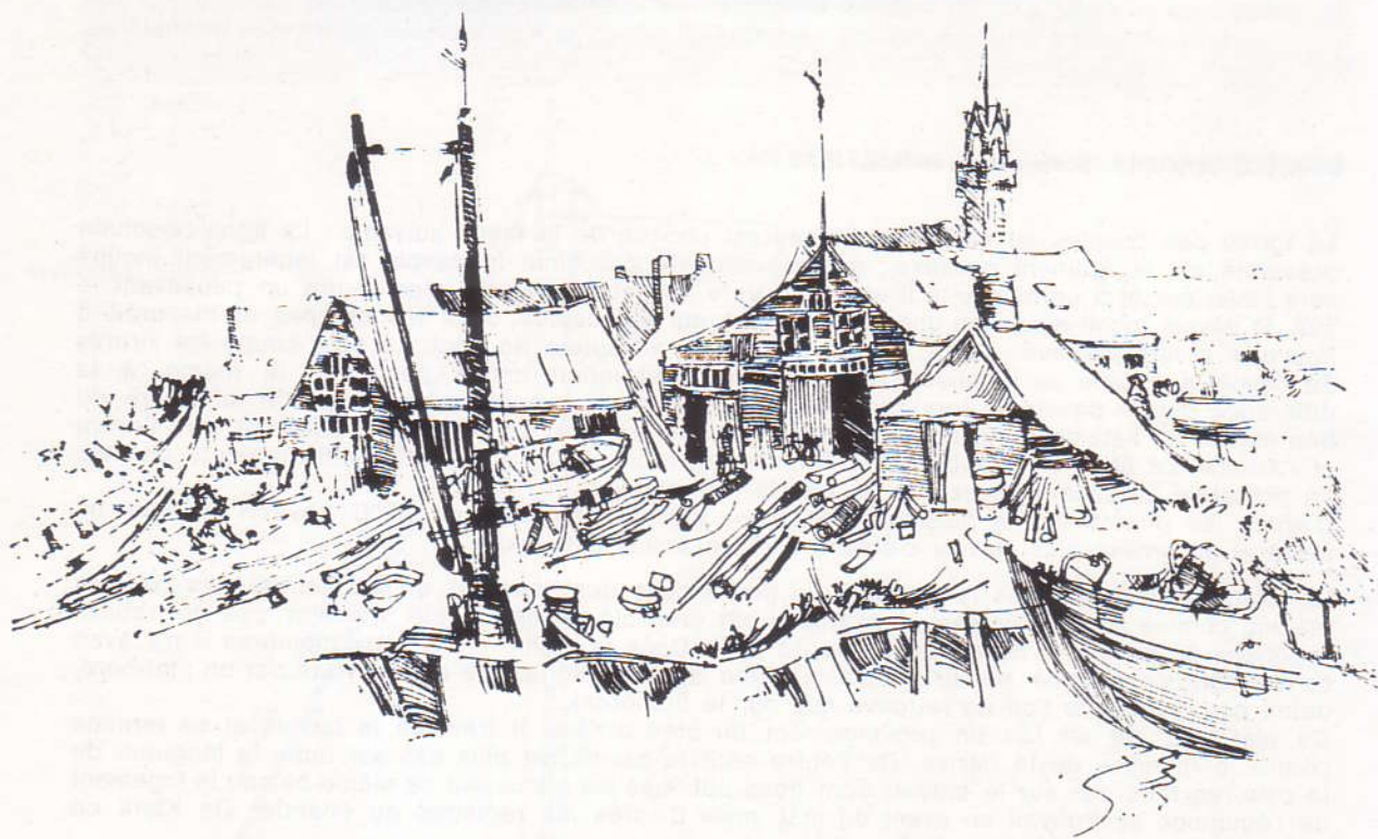
H .REINHOUT. Le chantier Meerman à Arnemuiden.
